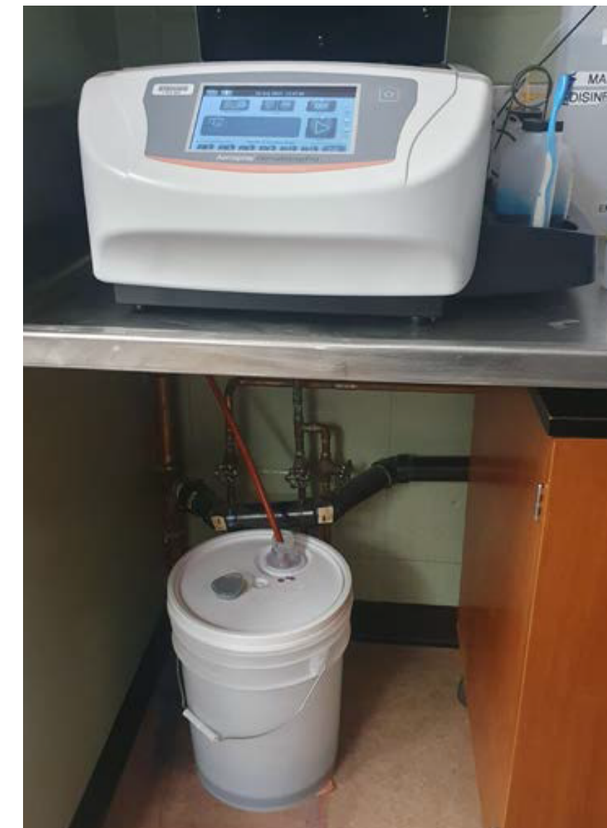
Figure 6 : Système de collecte des déchets liquides du colorateur de diapositives après deux semaines de collecte.
